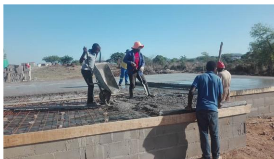
I lördags gjöt man betonggolvet
